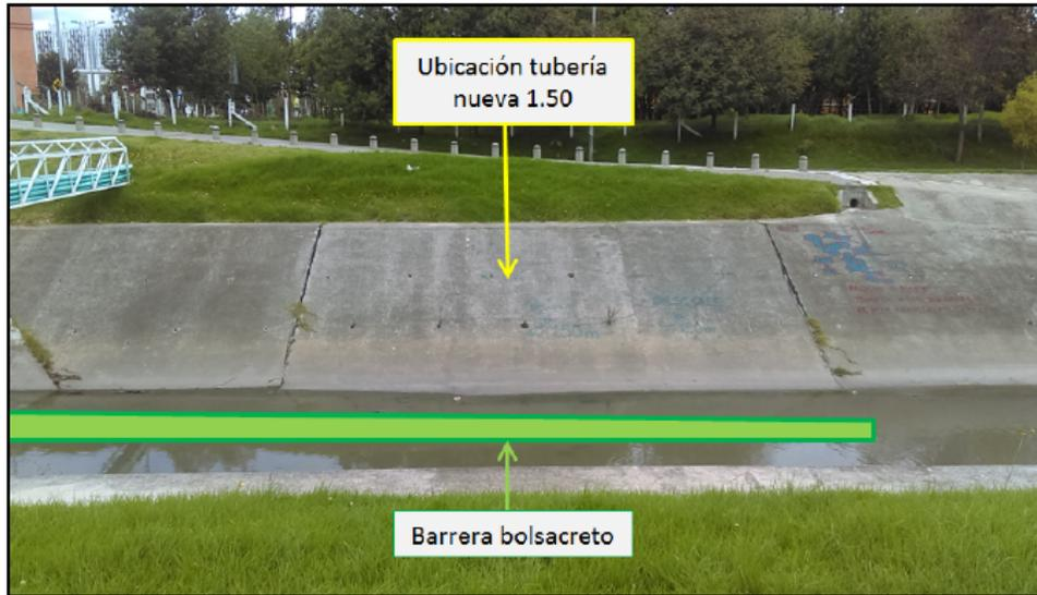
**Fotografía No. 2.** Ubicación de la zona de intervención tubería 1.50. Se relaciona la ubicación de la nueva tubería y la barrera de bolsacreto a instalar en el sector nor-occidental del canal Torca.
