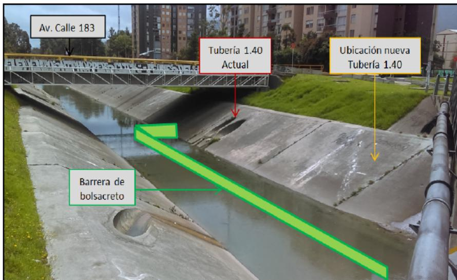
**Fotografía No. 3.** Zona de intervención en el Canal Torca para la tubería ubicada en el sector sur-oriental.
